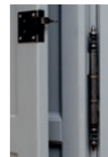
Paumelle turlupet à plaque vissée pour la fenêtre et le volet intérieur
